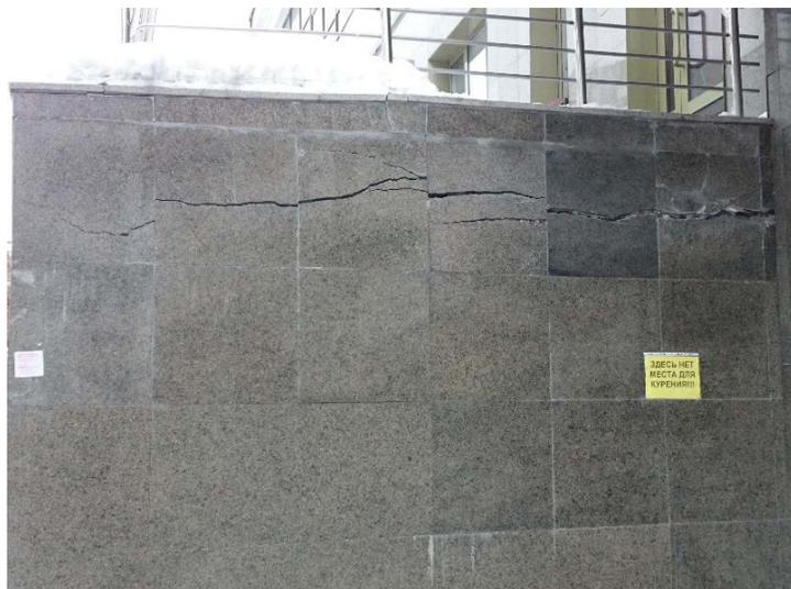
Образование трещины в стене отмостки.
