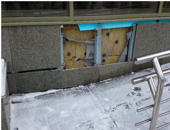
Отсутствуют облицовочные гранитные плиты со стороны 3 подъезда.
