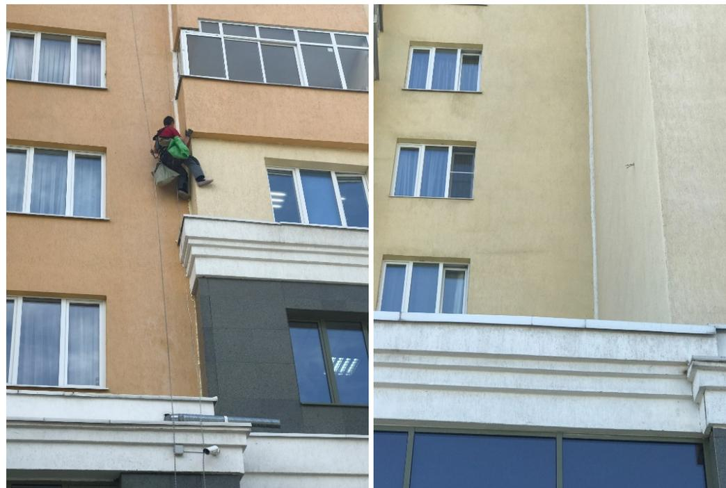
Проведено утепление и герметизация панельных швов. Благодаря проведенным работам во многих квартирах стало теплее.
