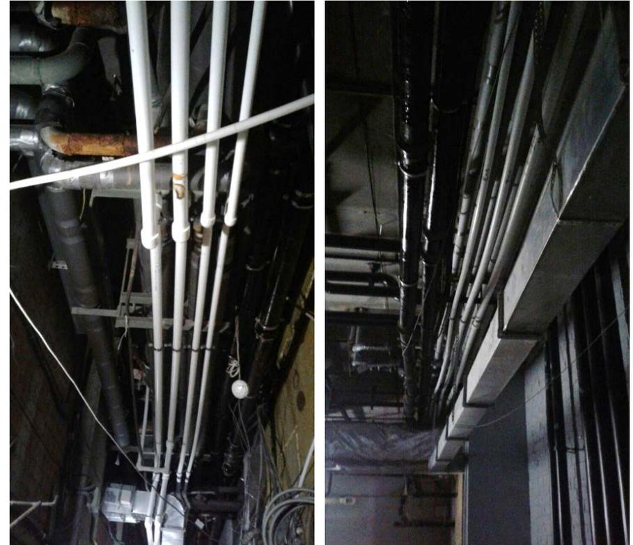
Проведен масштабный ремонт внутридомовых инженерных систем: заменены горизонтальные магистрали трубопровода ХВС и ГВС на современные полипропиленовые, заменена система циркуляции ГВС. Это привело к восстановлению температурного режима, улучшению качества поставляемой в квартиры воды.
