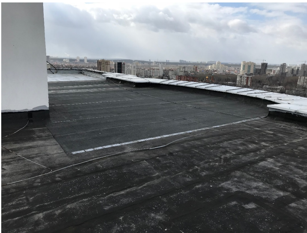
Произведен ремонт кровли 2 подъезда. Устранены причины протечек и затопления квартир.
