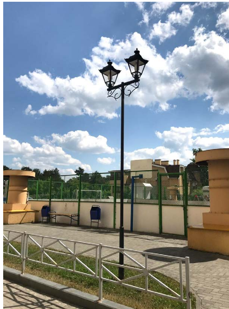
Установлены новые двойные светильники на фонарные столбы.
