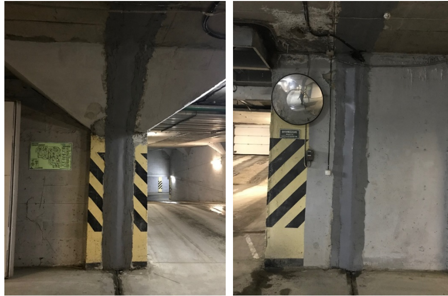
Произведена гидроизоляция паркинга на въезде.
