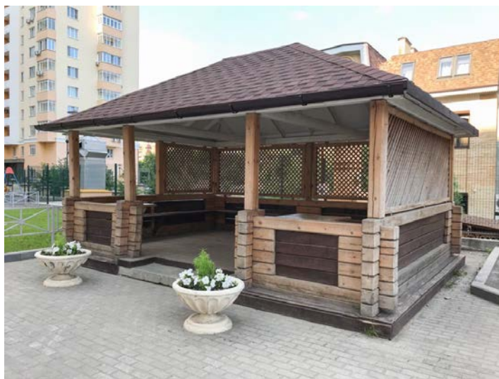
Проведено освещение в беседку.
