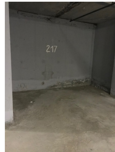
Устройство гидроизоляции деформационного шва, нижнего примыкания парковочного места №217.
