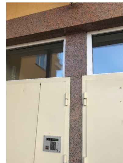
Проведены отделочные работы, восстановлен фасадный камень.
