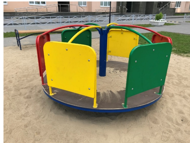
Установлена новая карусель.
