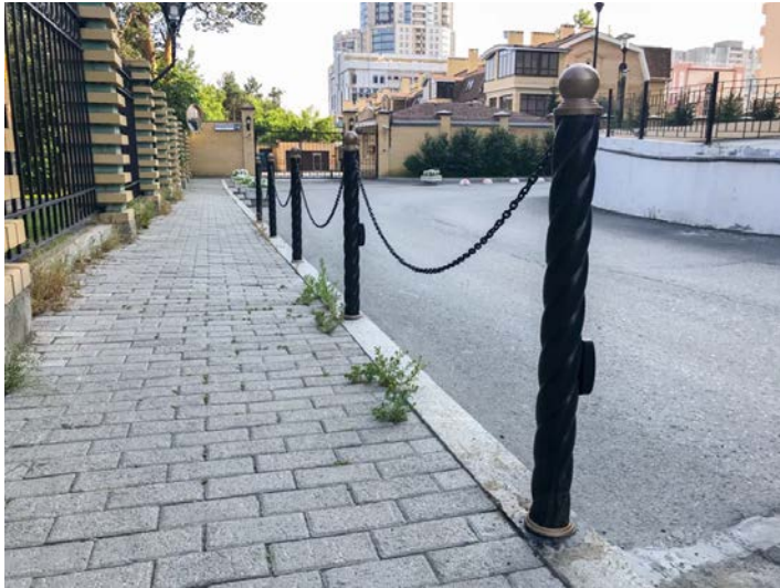
Установлены новые кованые парковочные столбики с цепью.
