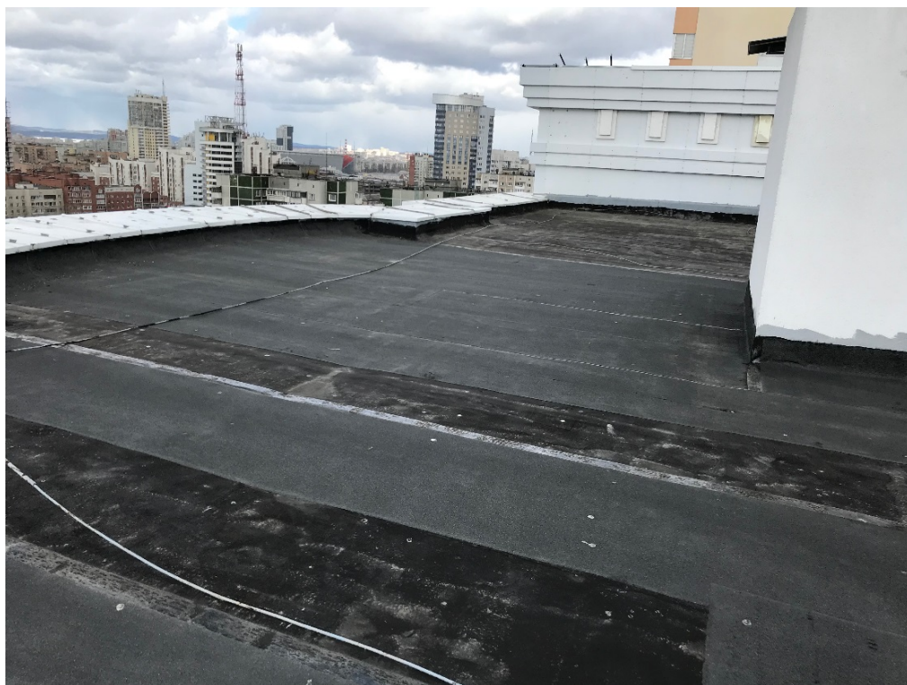
Произведен ремонт кровли 2 подъезда. Устранены причины протечек и затопления квартир.
