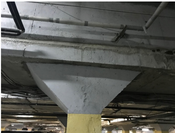
Произведено устройство гидроизоляции деформационного шва входной группы 1 подъезд (-1 этаж).
